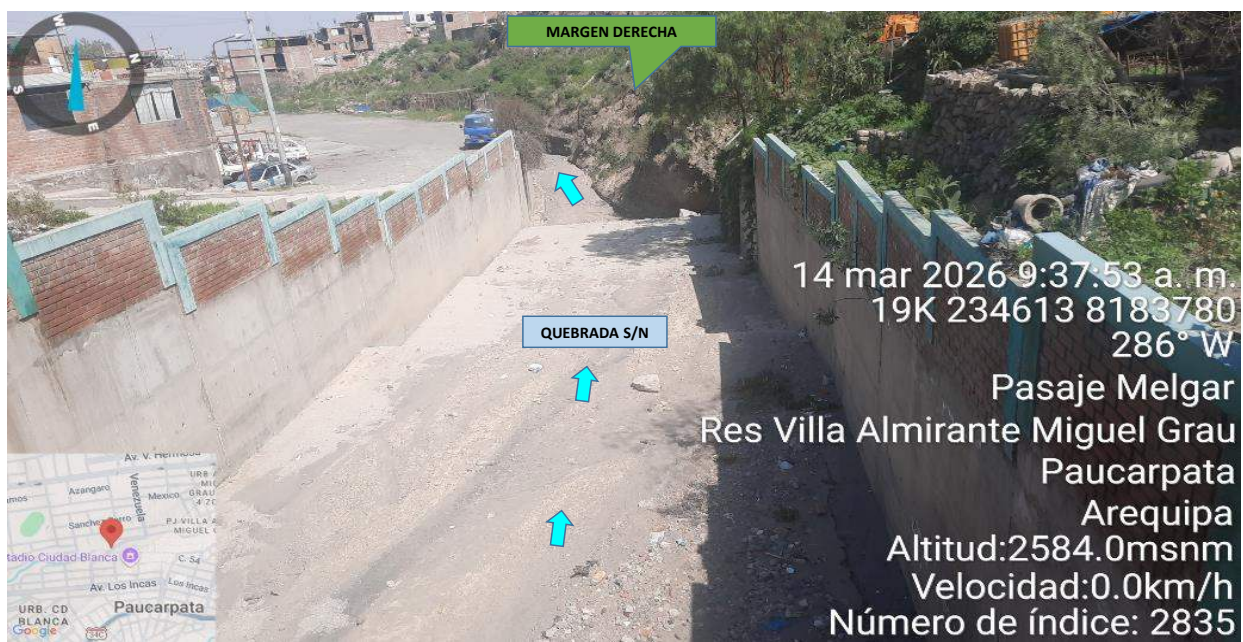
IMAGEN 03: EN UNA PARTE DE ESTE TRAMO SE OBSERVA EN LA MARGEN DERECHA DE LA QUEBRADA S/N, SE ENCUENTRA SIN PROTECCIÓN Y TAMBIEN VIVIENDAS CERCANAS AL CAUCE.
