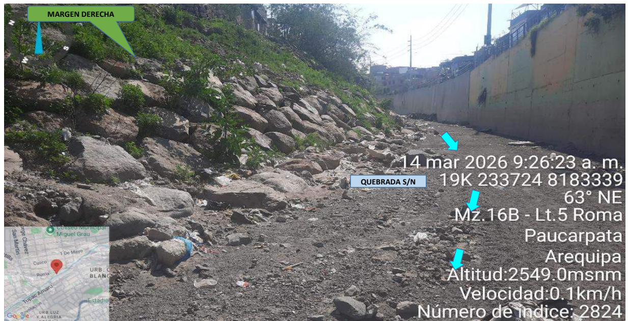
IMAGEN 02: EN ESTE TRAMO SE OBSERVA EN LA MARGEN DERECHA DE LA QUEBRADA S/N, SE ENCUENTRA SIN PROTECCIÓN SOLO ROCA SUELTA EN SU TALUD.
